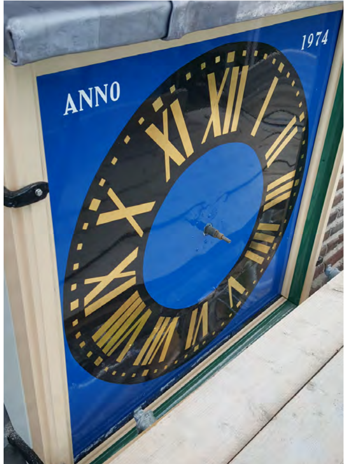
Wijzerplaat westzijde tijdens renovatie in 2021
