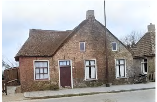
De voormalige woning aan Buorren 16: nu parkeerterrein
