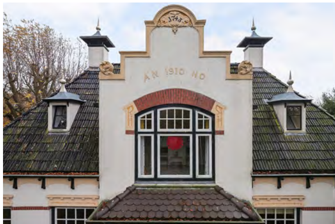
De nieuwe klokgevel uit 1910
