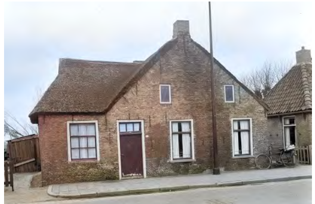
De voormalige woning aan Buorren 16: nu parkeerterrein
